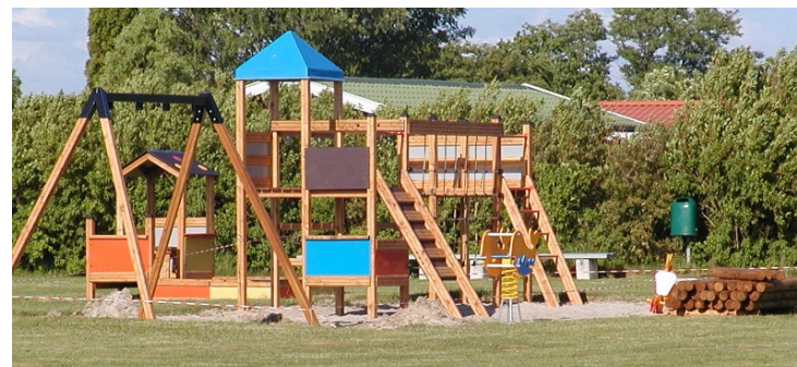
Den ny legeplads under opbygning
